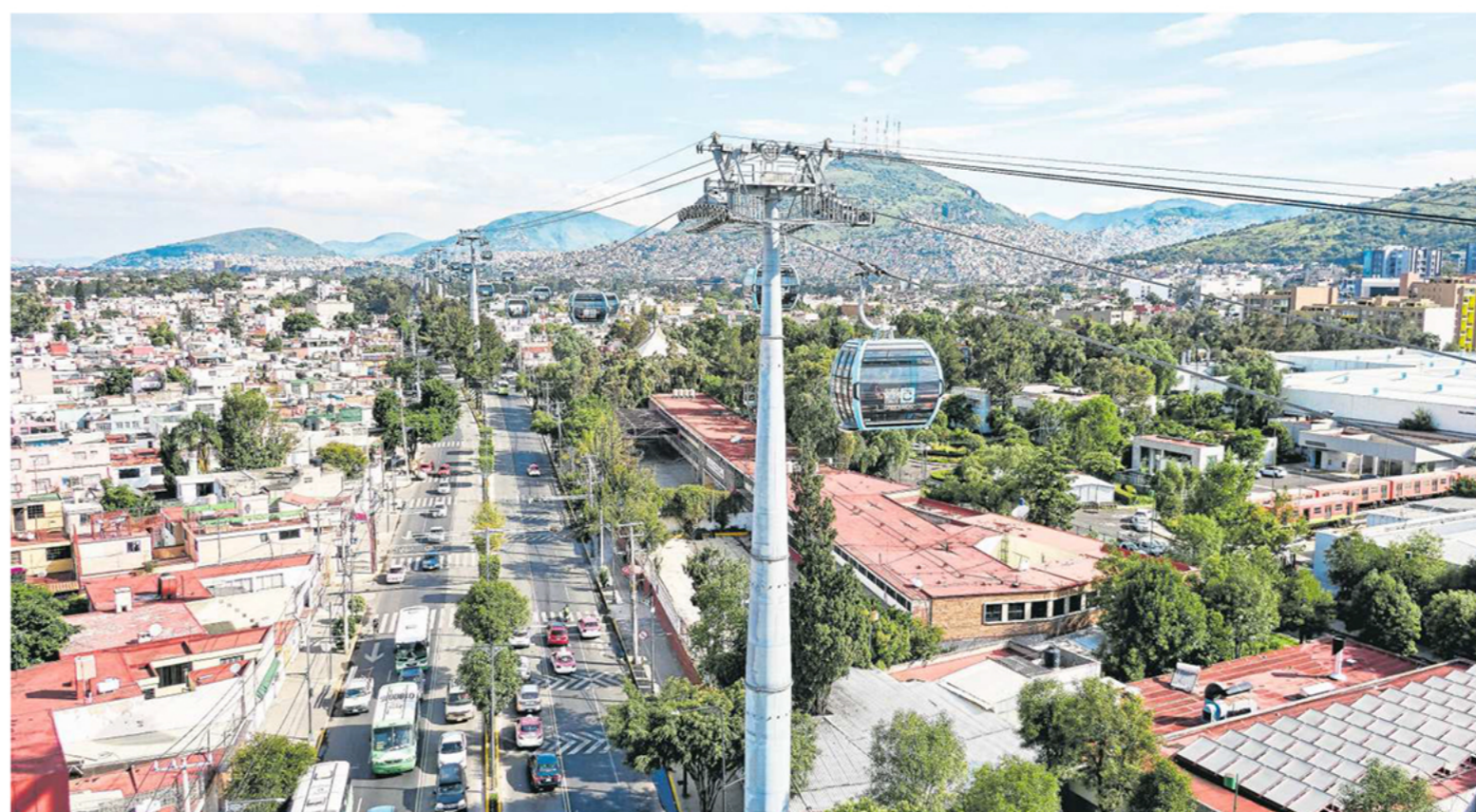
Seit 2021 bringt der Cablebus Línea im Norden der 20-Millionen-Metropole Mexiko City bis zu 144 000 Menschen pro Tag staufrei an ihr Ziel. Die Kabinen der Seilbahn wurden in Olten gemacht. Bild: zvg/Arturo Durán Miranda
